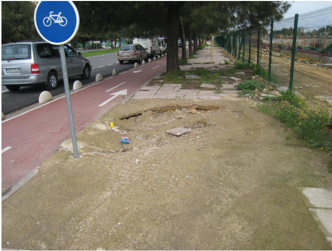
Los socavones alrededor de la excavación han profundizado más de 10 cm entre el 1 de Marzo y el 23 de Mayo
