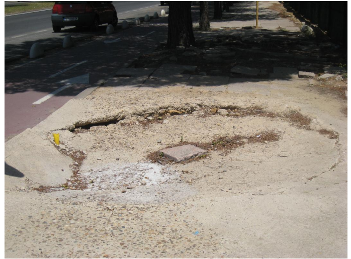
Los socavones alrededor de la excavación han profundizado más de 10 cm entre el 1 de Marzo y el 23 de Mayo
